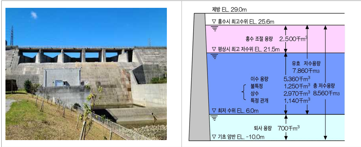
<그림 40> 킨댐 전경 및 용수 배분 현황
